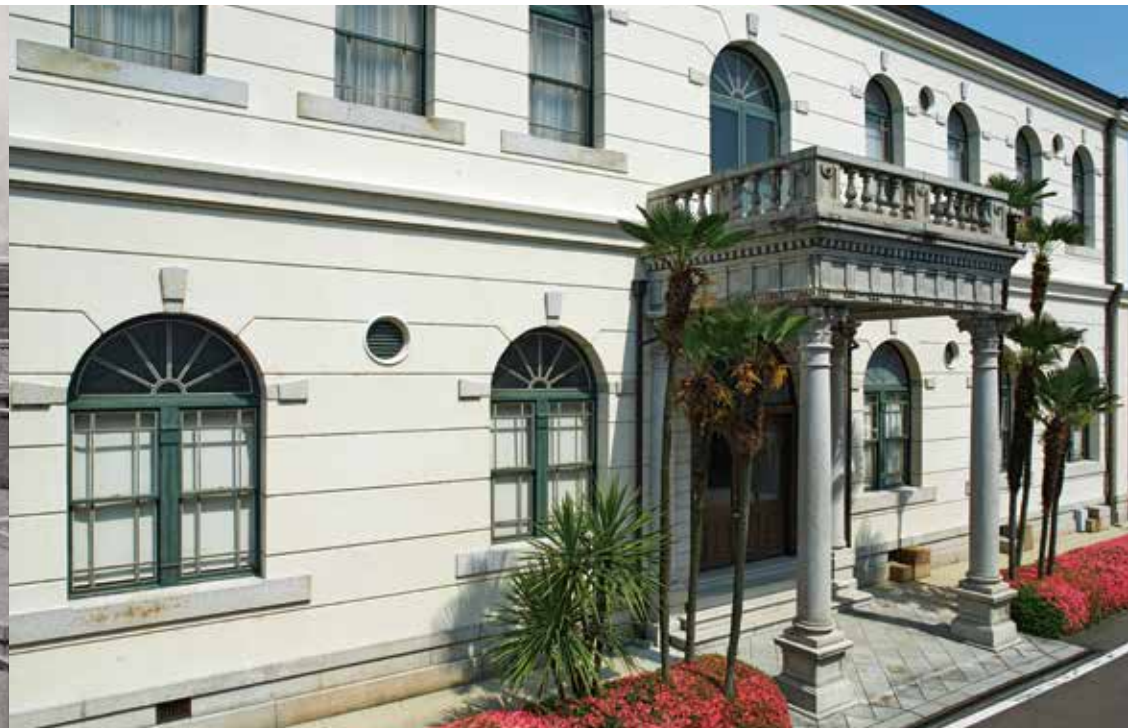
意匠を凝らしたバルコニーを支えるエンタシスの石柱 Stone columns with entasis supporting the elaborately designed balcony
